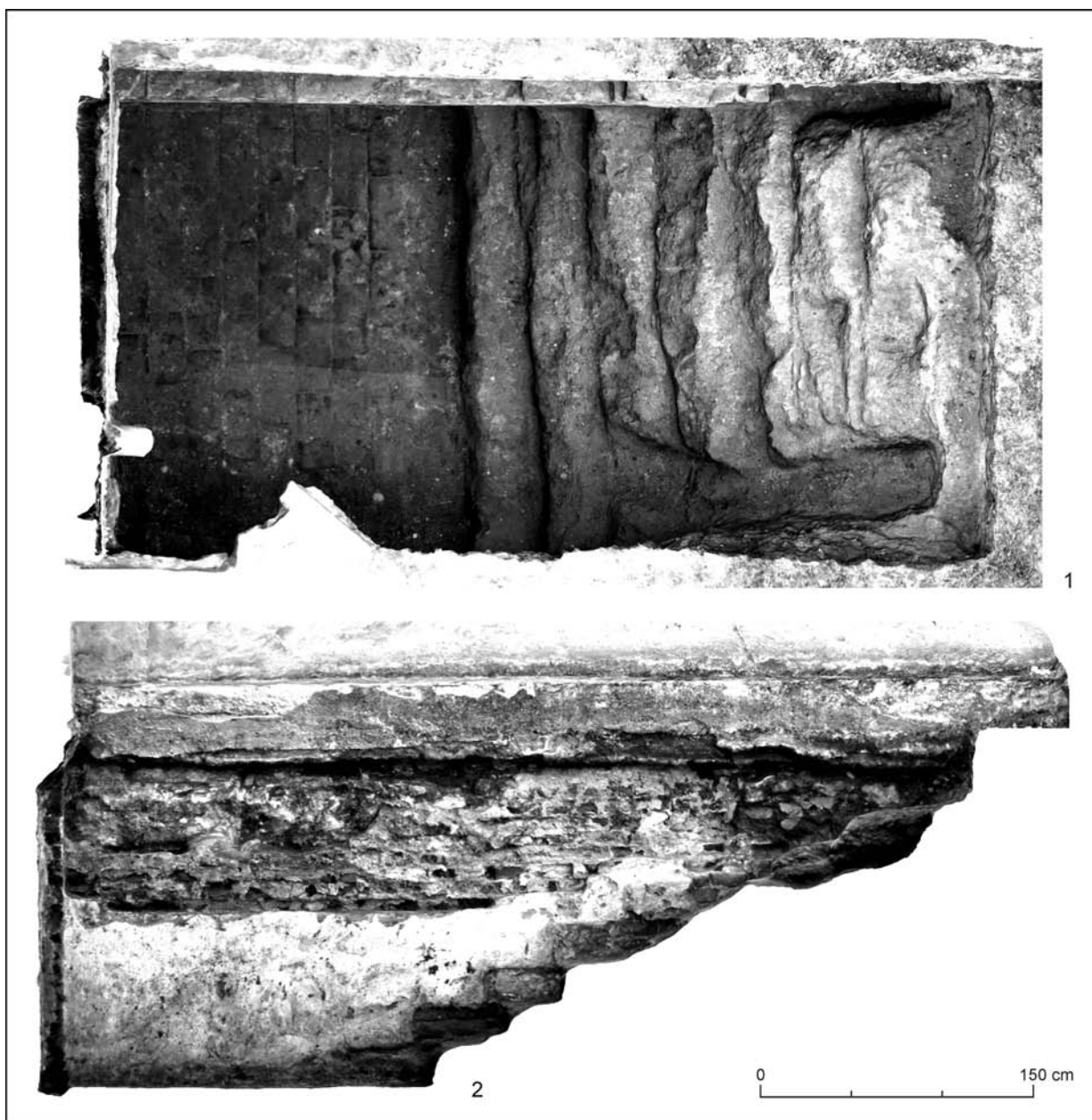
Obr. 3. Kovarce, Kostol sv. Mikuláša. Sonda 3A, vstupné schodisko do krypty pod severnou sakristiou. Vyhotovil B. Balžan, M. Bielich.
